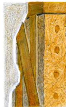
mur en pan de bois et torcbis enduit à la chaux
