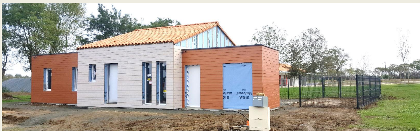
Travaux en cours
