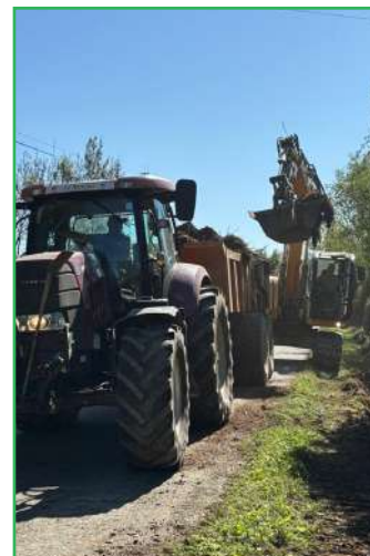
Curage des fossés
