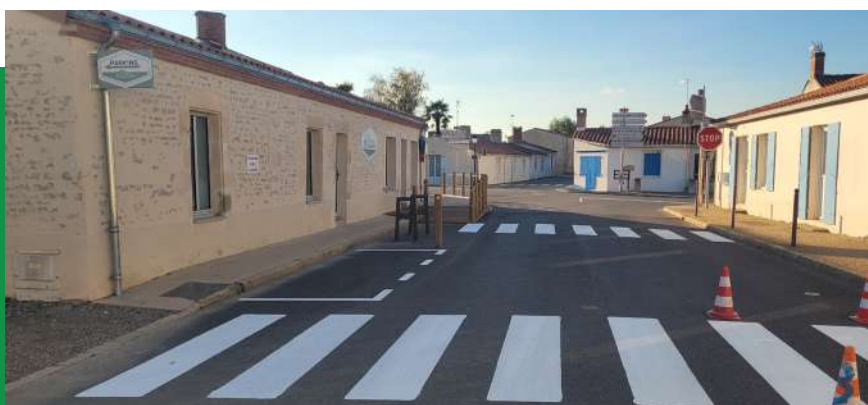
Aménagements et mise en place d'accès PMR et de passages piétons
