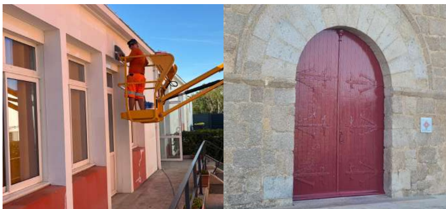
Travaux de peinture à l'école et sur les portes de l'église
