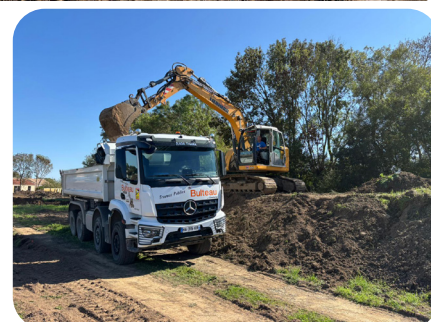
Début des travaux d'aménagement du lotissement du Parc de la Mairie 2 par les entreprises ATPR et Bulteau TP.
