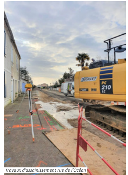
Travaux d'assainissement rue de l'Océan
